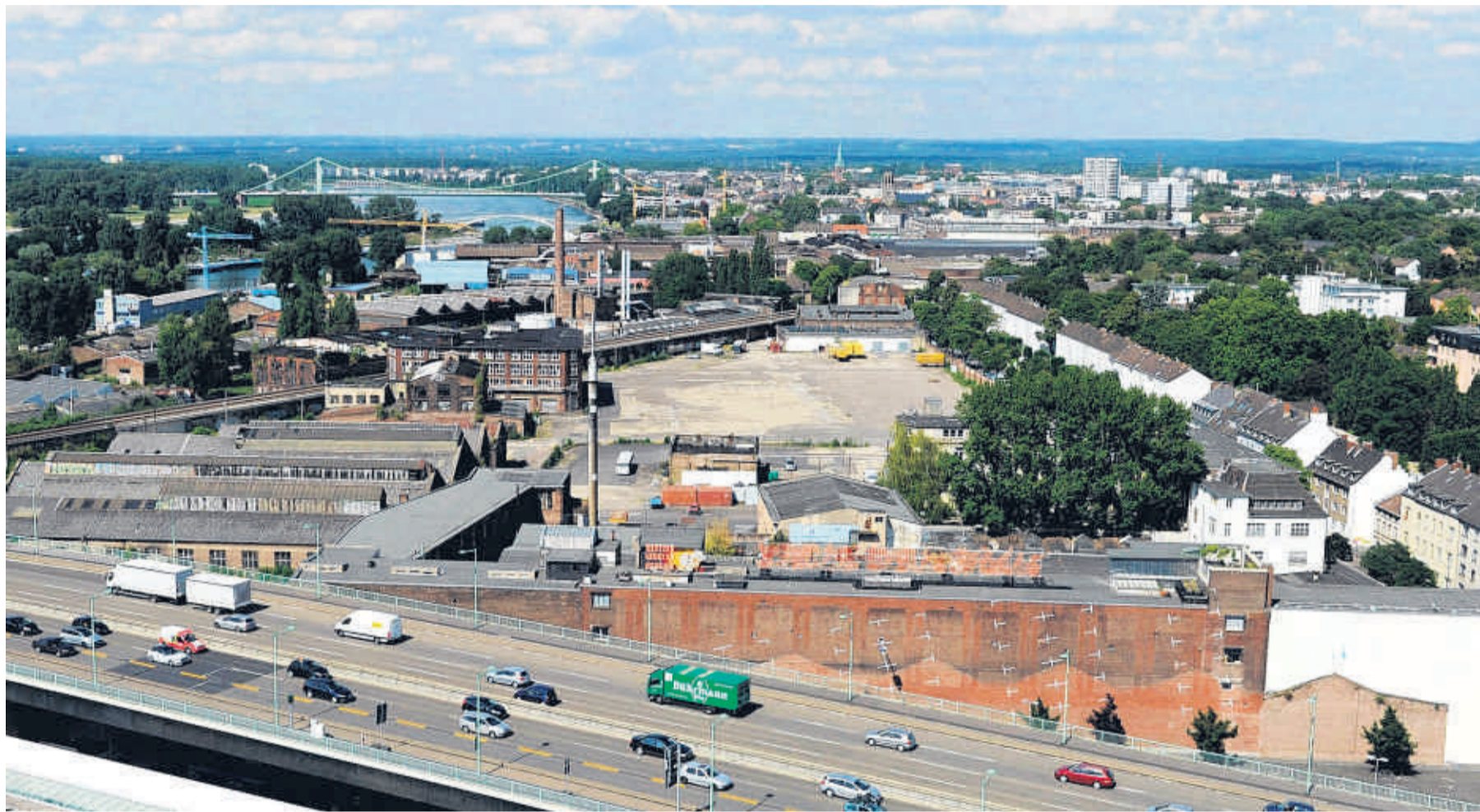
Das Areal nördlich der Zoostraße ist zum größten Teil noch Industriebrache. Nur einige Gebäude im Südosten (r.) werden genutzt.
